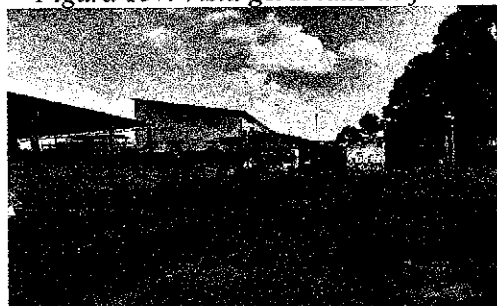
Figura 158. Vista geral lado de fora.
