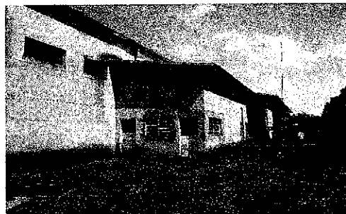
Figura 161. Vista geral lado de fora.
