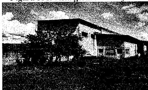
Figura 159. Vista geral lado de fora.
