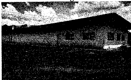
Figura 2. Pavimento 1: Vestiários, Refeitório e cozinha.
