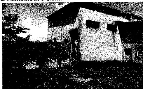
Figura 160. Vista geral lado de fora.
