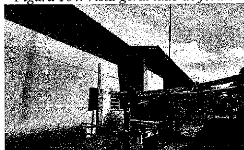
Figura 165. Vista geral lado de fora.
