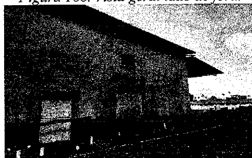
Figura 168. Vista geral lado de fora.
