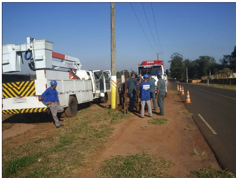
Empresa concessionária de energia elétrica está trabalhando no alinhamento dos postes
