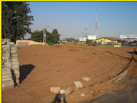
A obra está sendo executada com recursos do DADE
