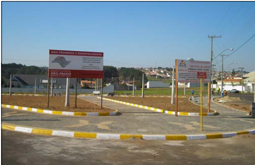
A construção da praça está na fase final
