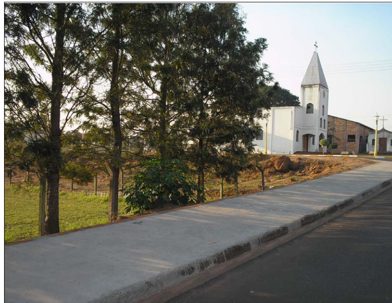
Calçada beneficiará a circulação de pessoas no local
