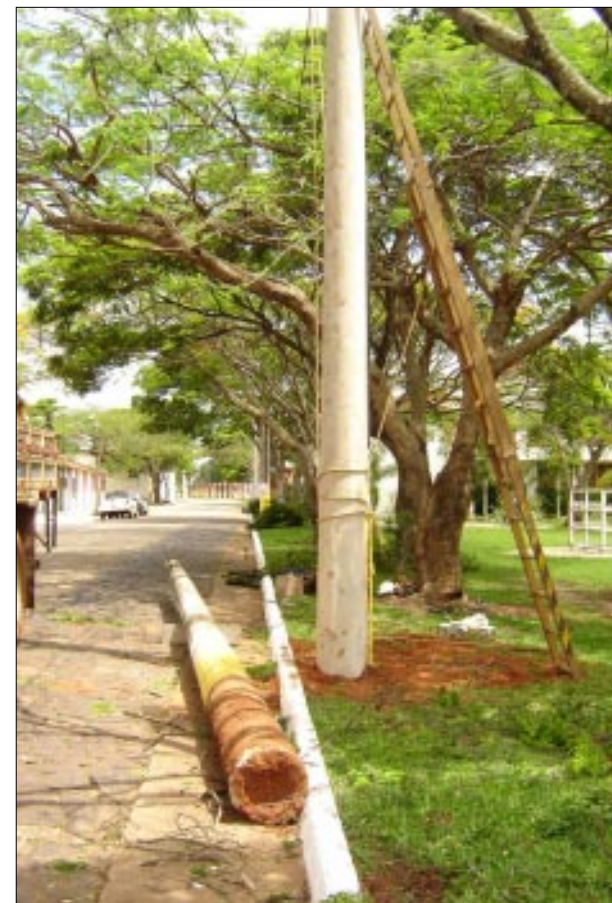
Rede de Energia está sendo recuperada
