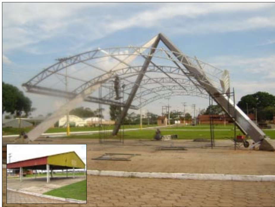
Barracão está recebendo nova cobertura (no detalhe a cobertura antiga)
