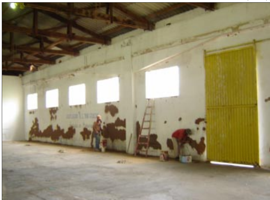
Hangar está sendo reformado
