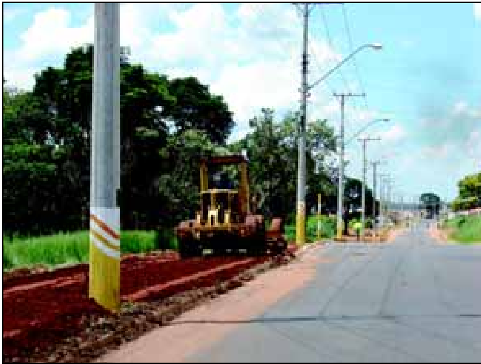
A avenida é o principal acesso ao Bairro do Camargo
