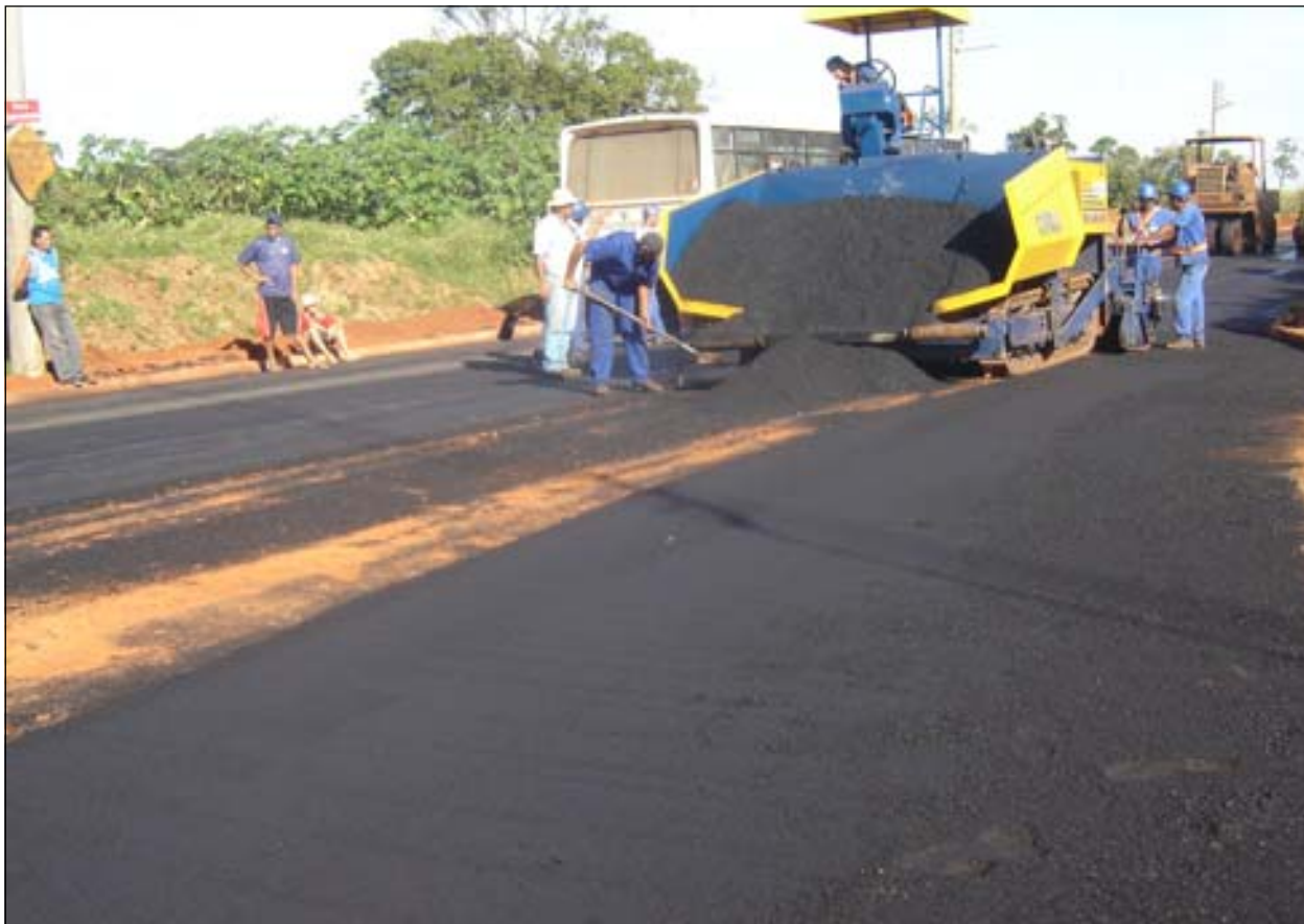
Trabalhadores acertam os últimos detalhes na Rua Álvaro Filgueiras
