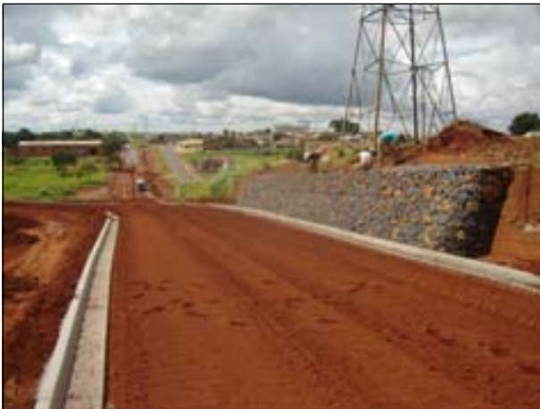
Foi necessário fazer muro de arrimo para garantir a sustentação da torre de energia
