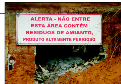
A antiga empresa AUCO enterrou o produto antes de deixar Avaré
