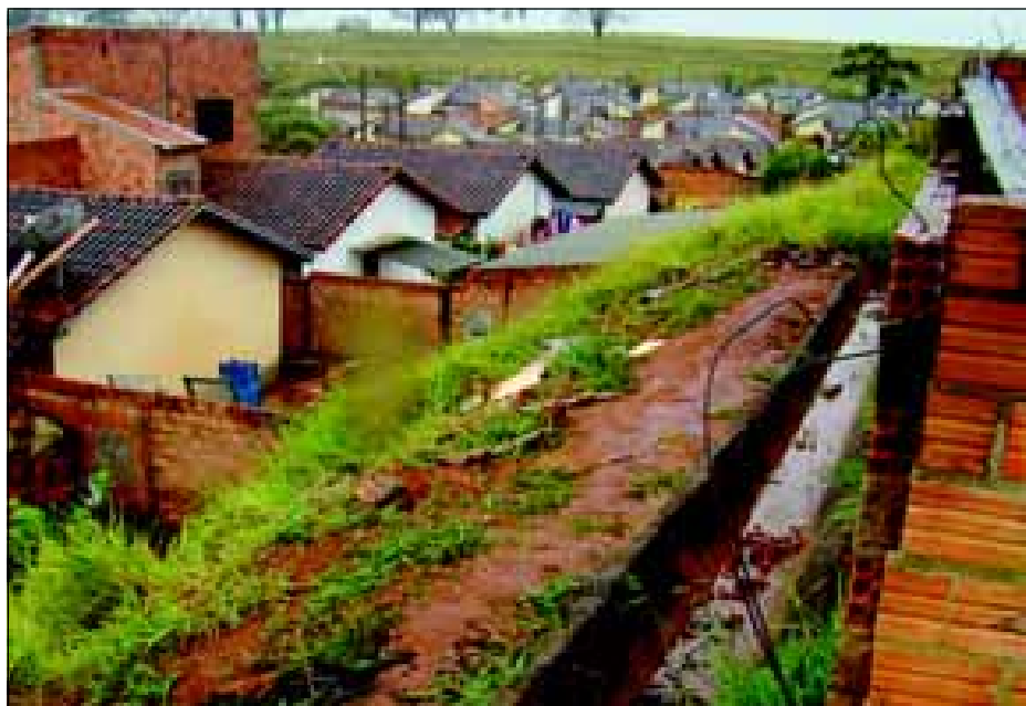
Local onde será construído o muro de arrimo
