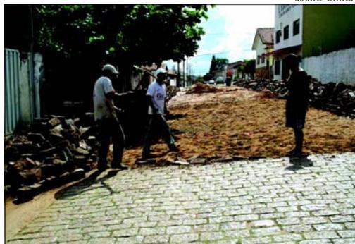
O antigo calçamento em paralelepípedos está sendo retirado para a colocação de lajotas
