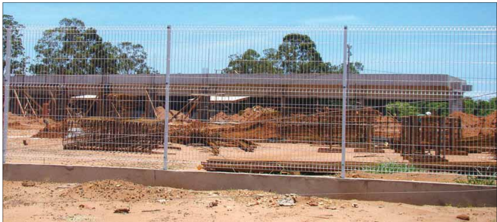
Obra da futura escola do Sesi: construção está a todo vapor
