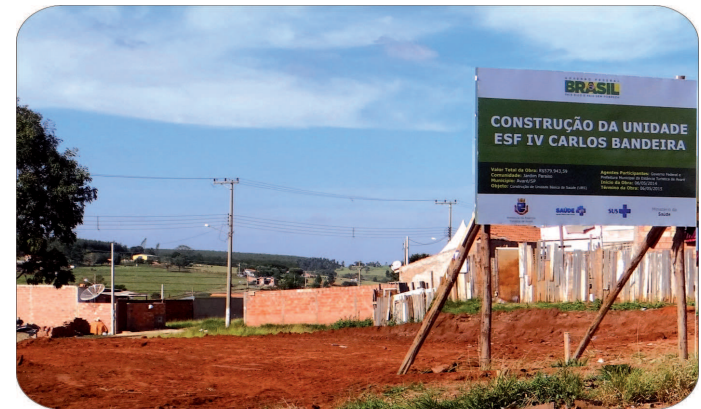
Construção da UBS no Jardim Paraíso
