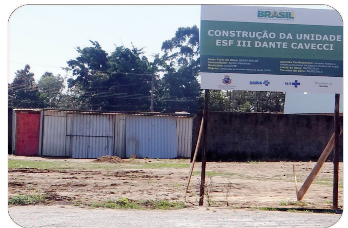
Construção da UBS no Jardim Paineiras
