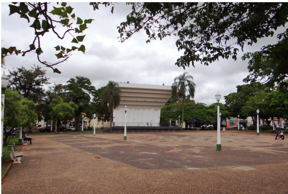
Praça Prefeito Romeu Bretas terá obras nos quiosques
