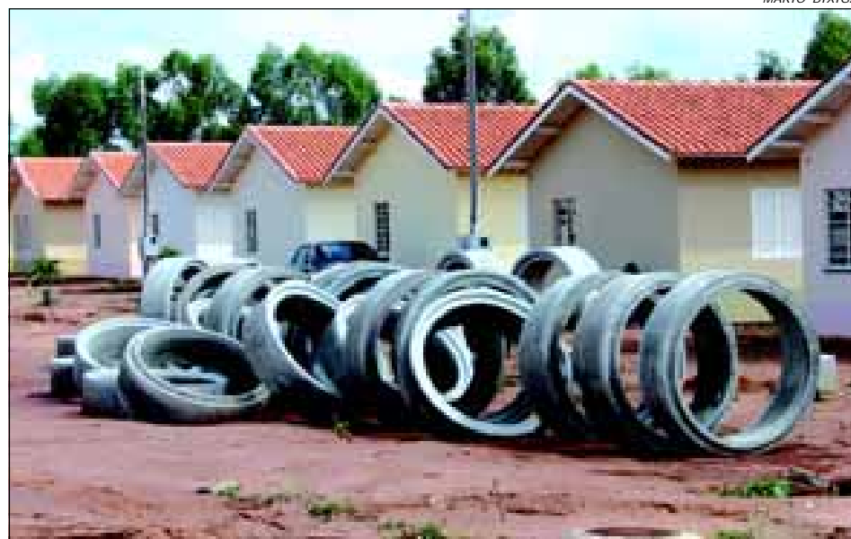
Esta obra é de fundamental importância para habitabilidade das unidades
