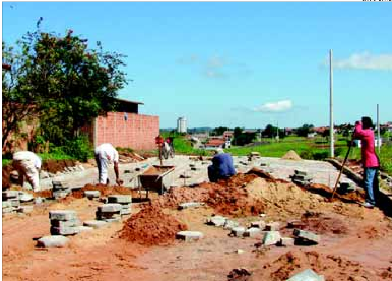
A obra possibilitará uma interligação entre as ruas Carmem Dias Farias e Três Marias.
