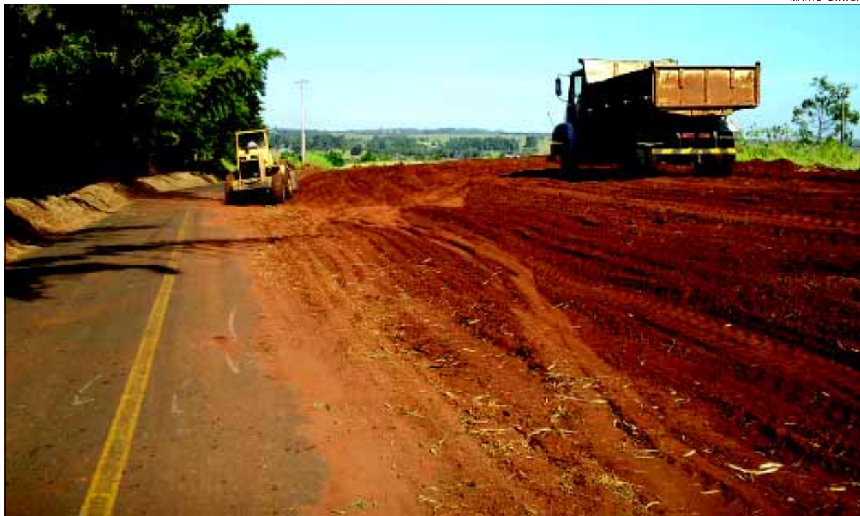
Os trabalhos estão concentrados nas curvas que levam mais perigo
