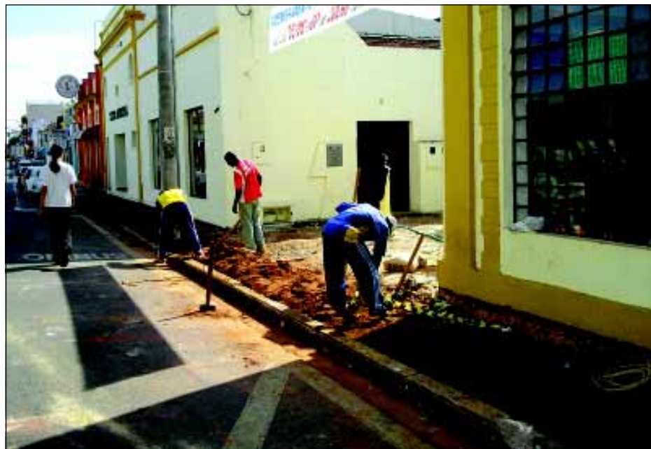
No local a Prefeitura está extraíndo a antiga calçada de concreto
