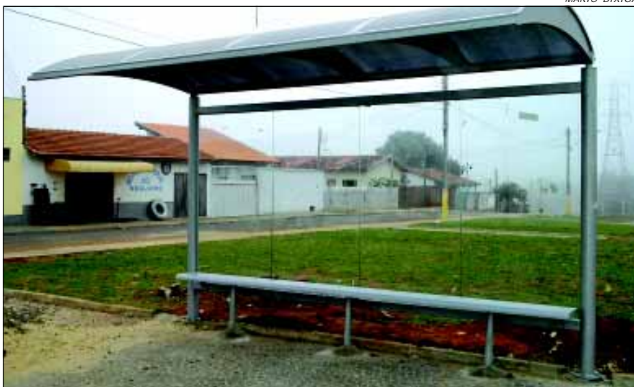
Primeiro ponto foi instalado no Bairro Vera Cruz
