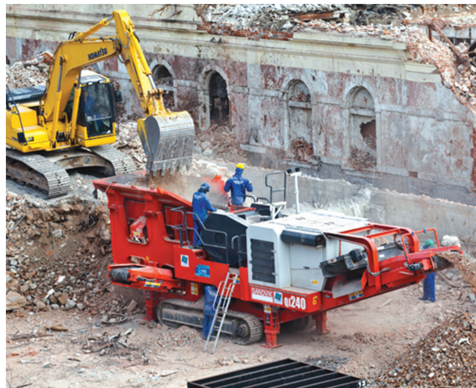
A máquina tritura o entulho, que pode ser aproveitado como cascalho em estradas rurais e reutilizado na construção civil
