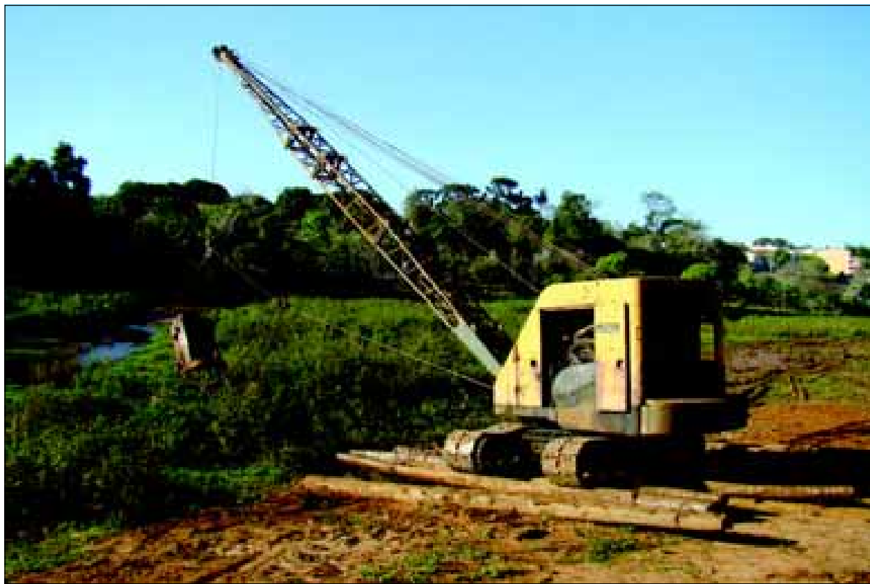
Dragline trabalhando na recuperação do lago do Horto
