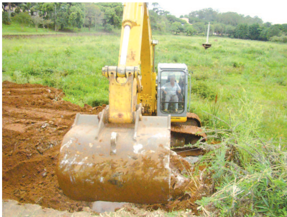
Máquina trabalha na reconstrução da barragem do Horto
