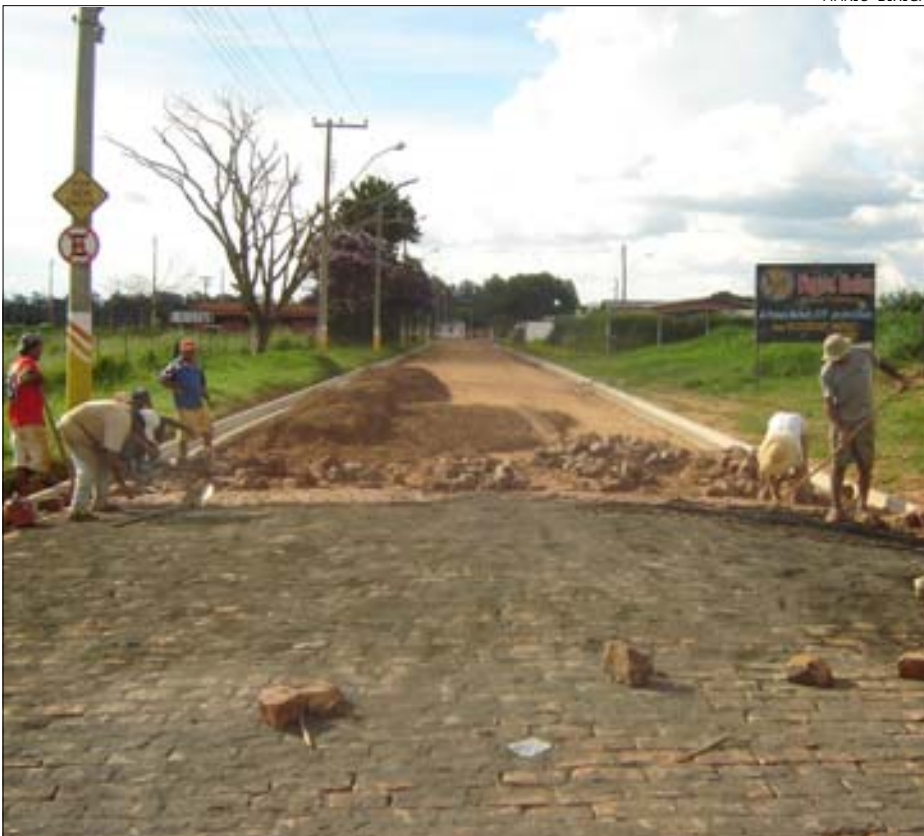
A rua está recebendo pavimentação em paralelepípedos
