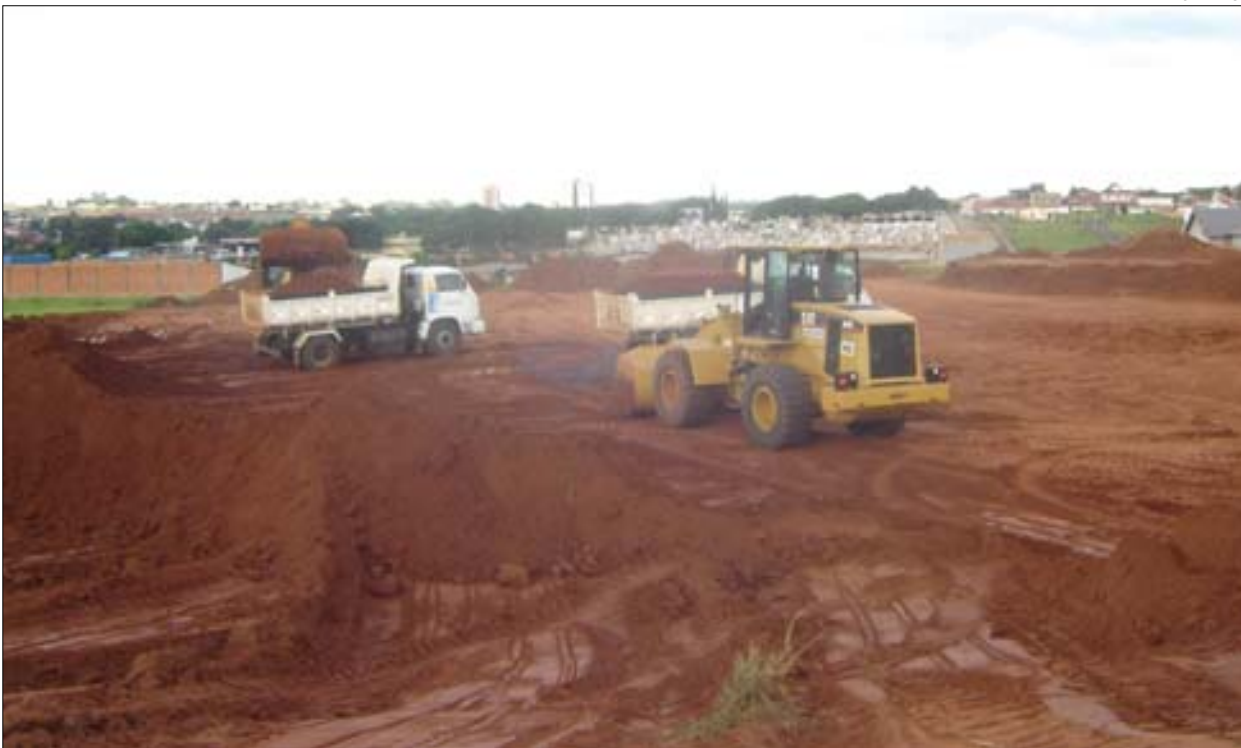
De início estão sendo feitos os trabalhos de terraplanagem
