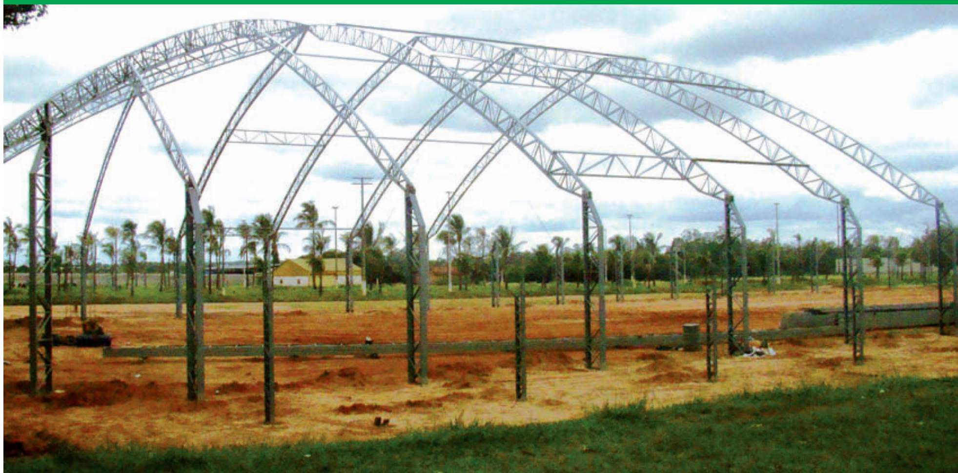
Construção da nova pista coberta do Parque "Fernando Cruz Pimentel"
