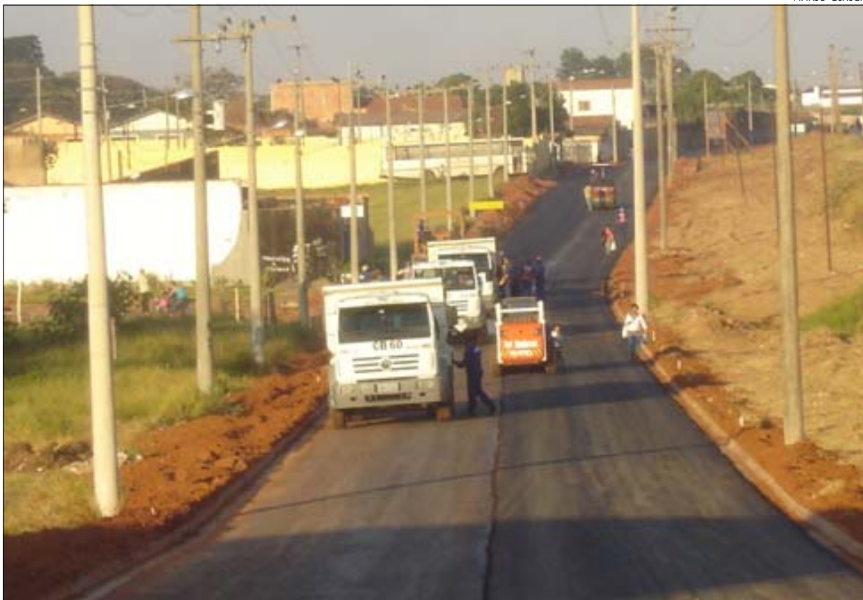
A Rua recebeu pavimentação asfáltica em um trecho de 700 metros
