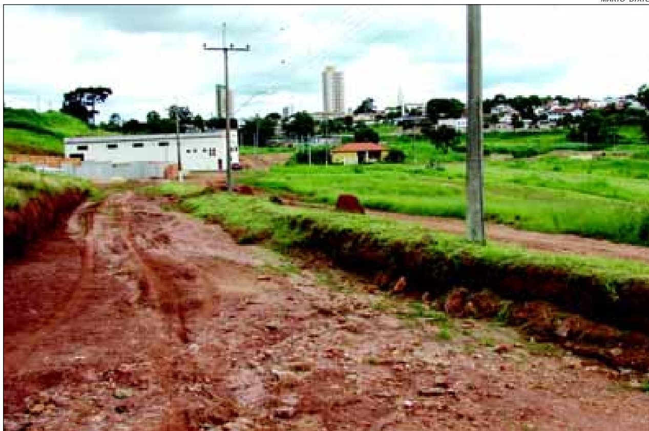
Inicialmente a Prefeitura está realizando o trabalho de limpeza do local
