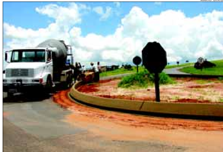
Canteiro central está recebendo guia alta
