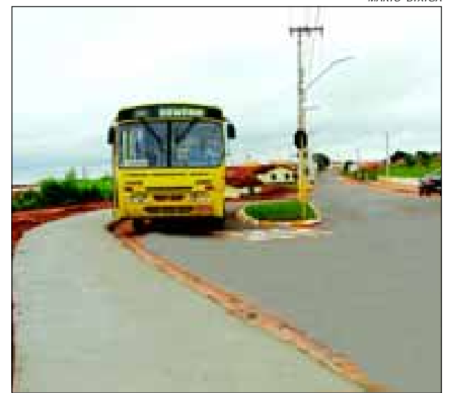
Rotatória e calçada garantem segurança para motoristas e pedestres
