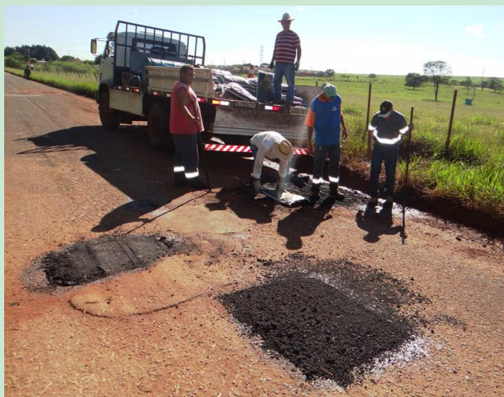
Operação Tapa-buracos na estrada da Barra Grande
