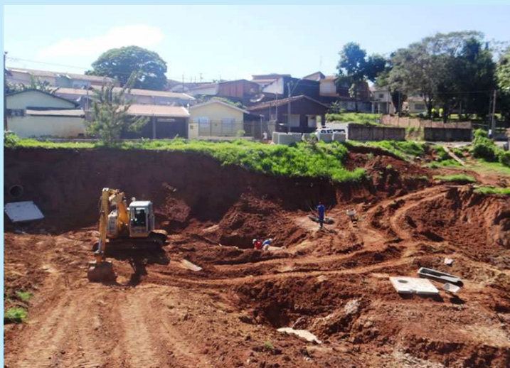
Obras na Rua Roldão Euphrasio Leal
