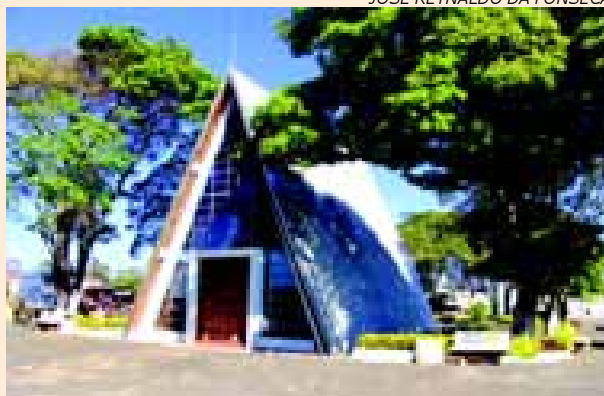
Capela ecumênica do Cemitério atual, obra de 1961.
