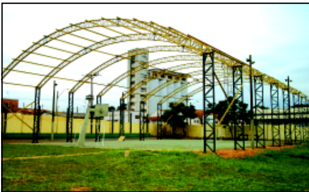
Prefeitura está realizando a cobertura da Escola Elizabeth Jesus de Freitas
