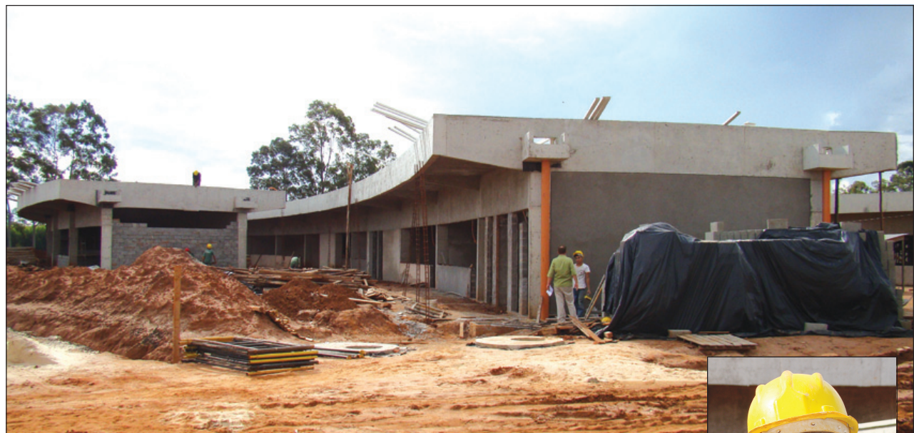
Construção da Escola do SESI
