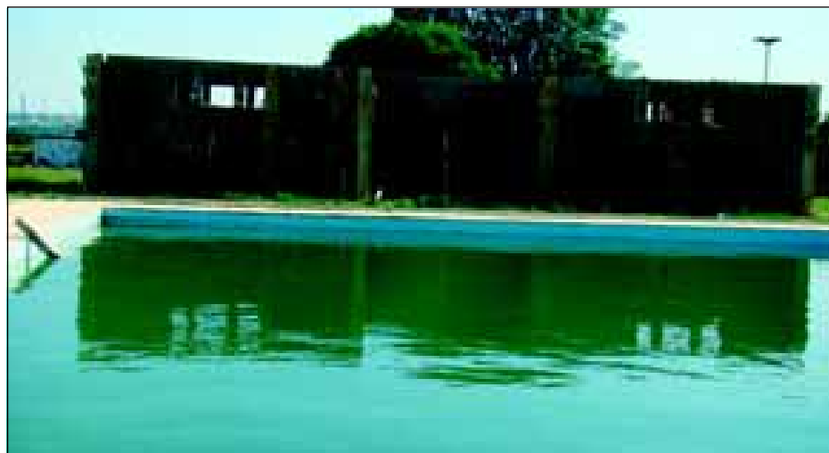
Construção dos vestiários da piscina do CSU
