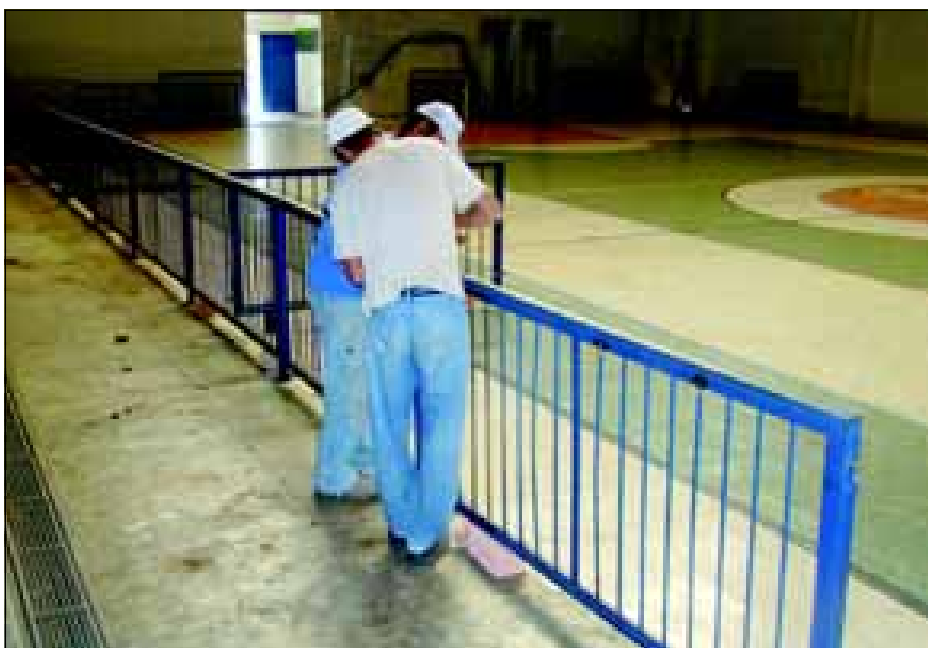
Colocação dos alambrados do Ginásio "Tico do Manolo"
