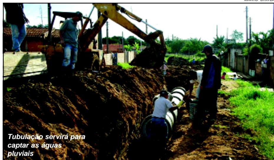
Tubulação servirá para captar as águas pluviais
