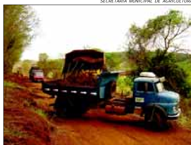
Máquinas durante a readequação da estrada dos Rochas
