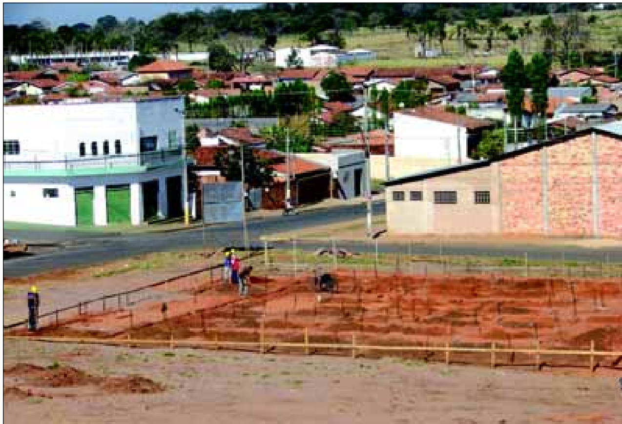
PAS em construção no Santa Elizabeth
