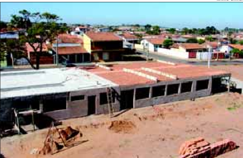
Escola Infantil em construção no bairro Santa Elizabeth
