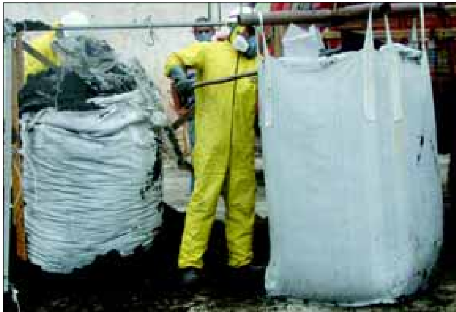
Amianto sendo embalado para ser retirado de Avaré
