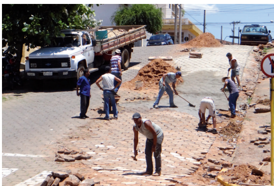
Serviço de manutenção na pavimentação na Rua Minas Gerais
