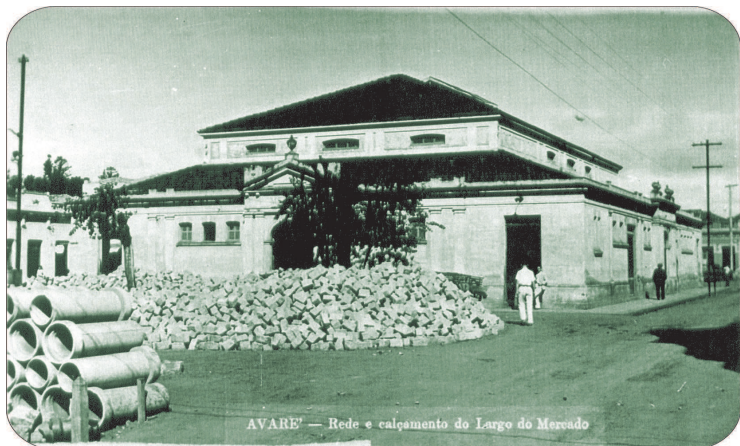
Obras de saneamento básico, 1938
