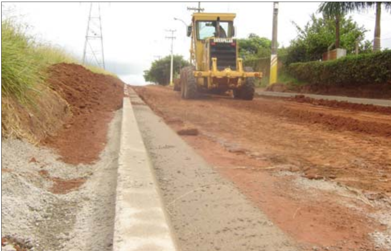
O trabalho foi iniciado com a regularização do terreno e a colocação de guias e sarjetas
