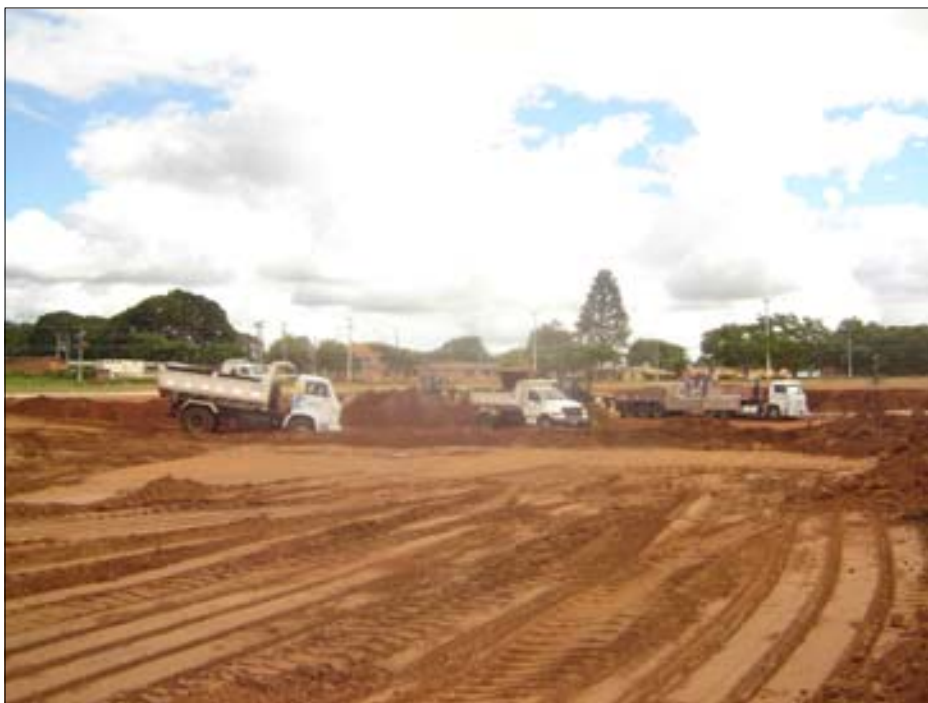
Os trabalhos estão em ritmo acelerado
