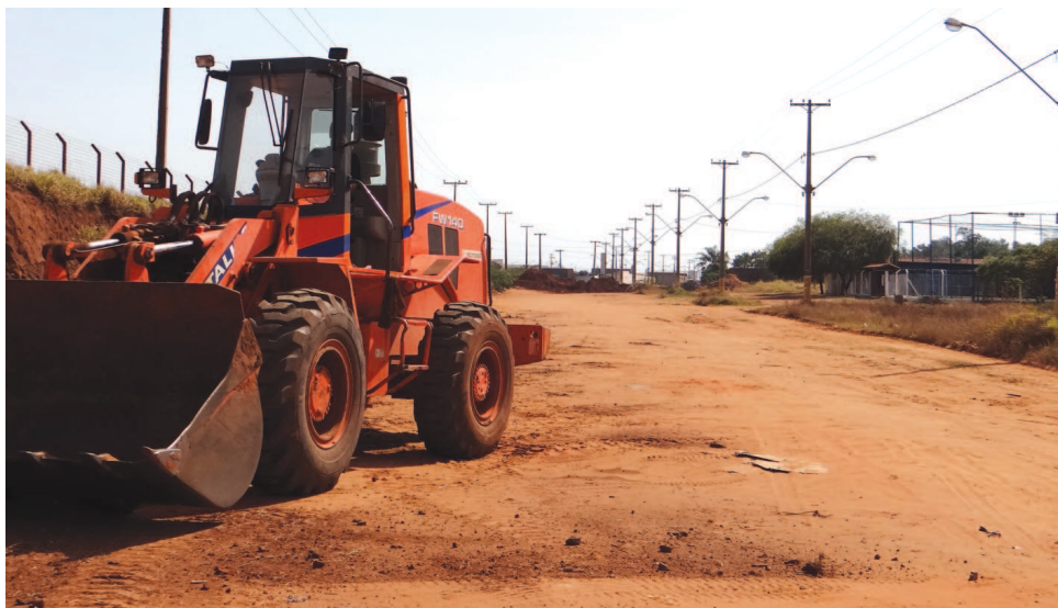
Terraplanagem da Avenida Antônio Silvio Cunha Bueno
