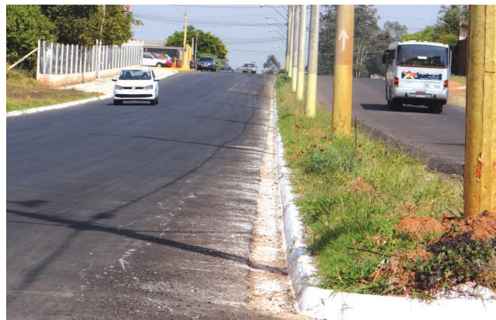
Asfalto Avenida Governador Mário Covas
