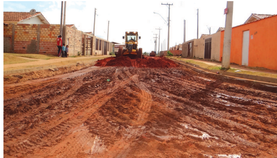
Terraplanagem do Conjunto Avaré F1 e F2
