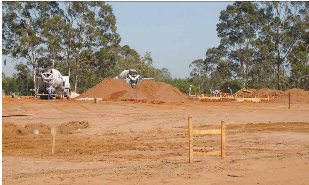
Obras da futura escola do Sesi já estão em andamento
