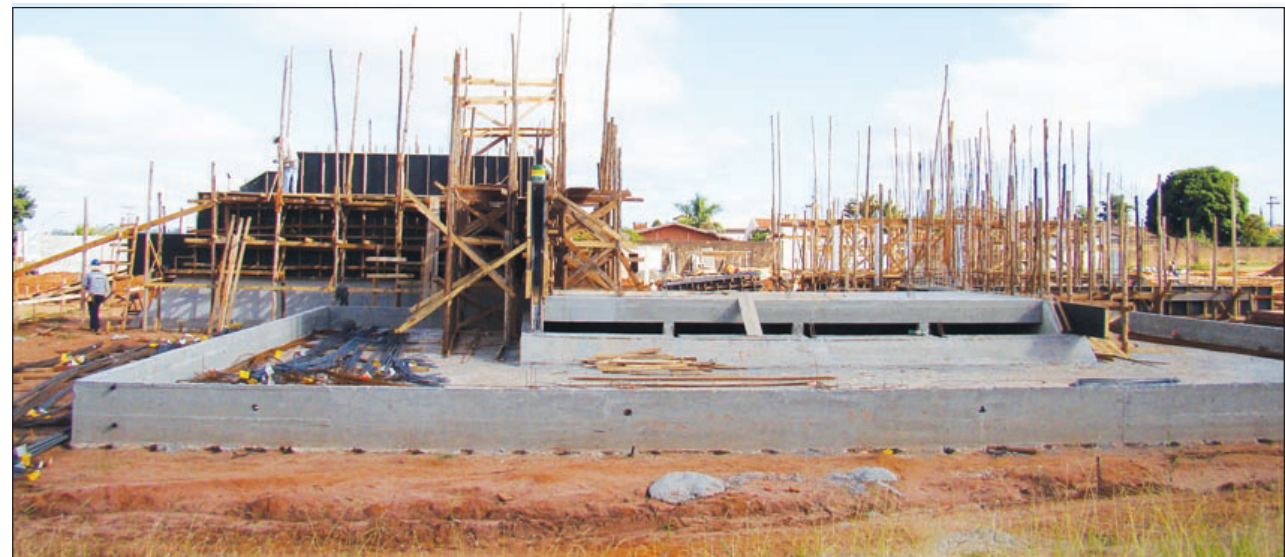
Obras do novo prédio do Fórum
