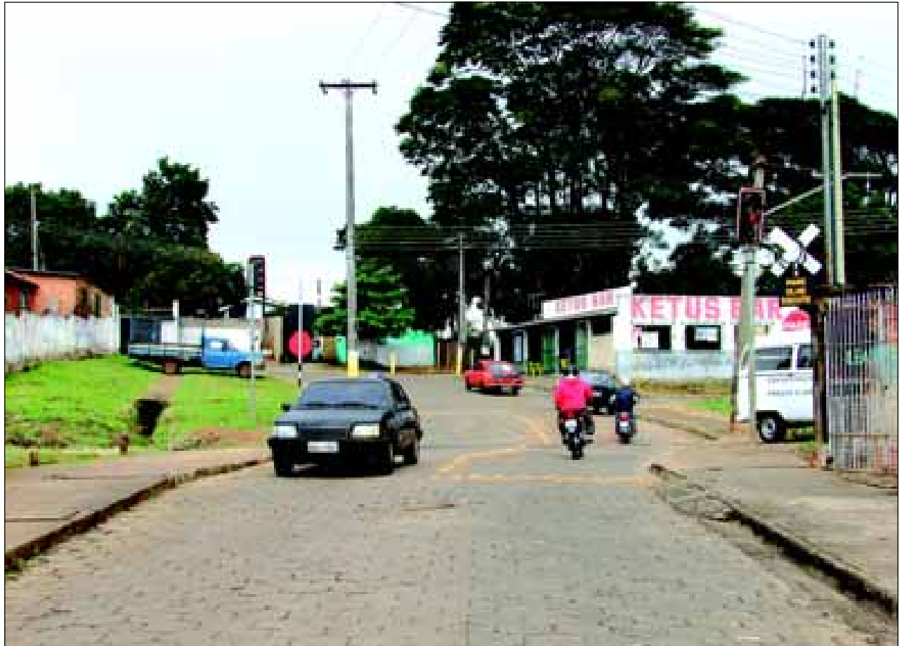
Acesso ao bairro Plimec, palco de inúmeros acidentes e atropelamentos em face da ferrovia
