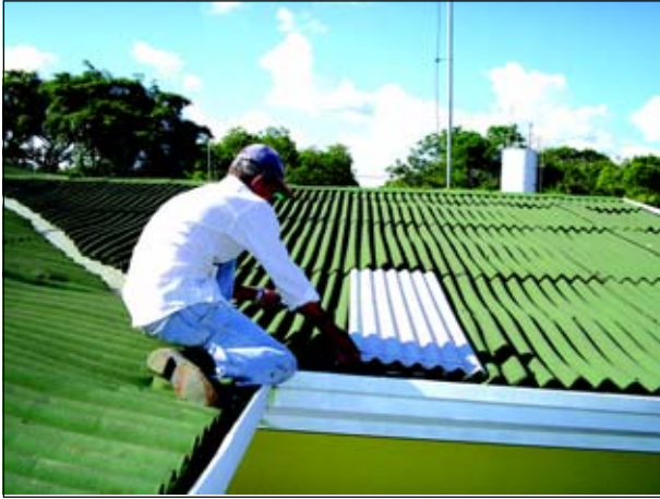
Telhas deterioradas estão sendo trocadas
