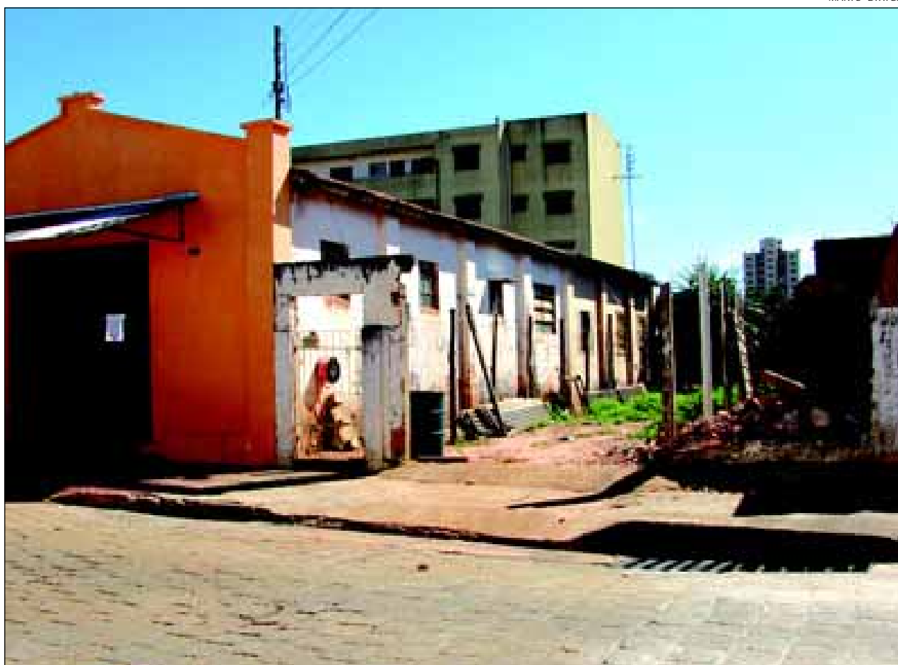
Imóvel adquirido pela prefeitura para dar início as construções contra inundações
