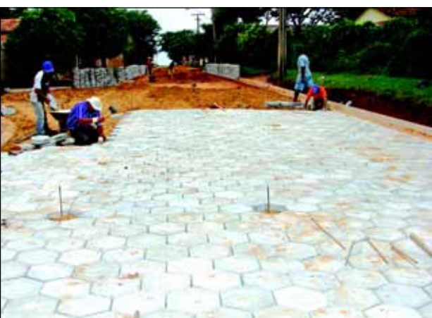
Estão sendo feitos pavimentação em lajotas e guias extrusadas das principais vias de acesso interno do bairro Costa Azul
