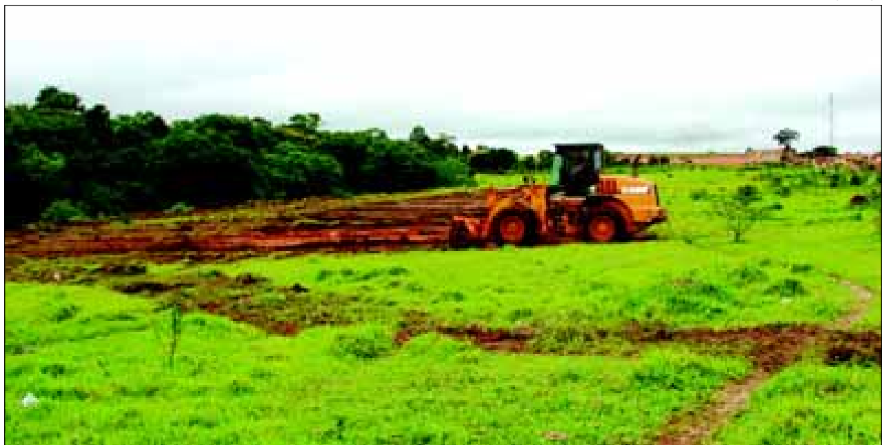
Maquinas da empresa vencedora iniciam terraplenagem da área onde será construída o novo prédio escolar
