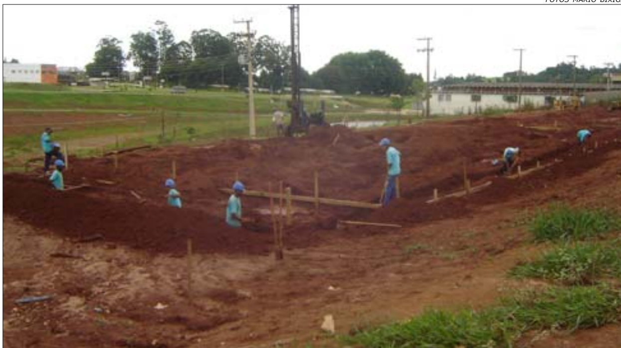
O prédio terá uma área construída de 600 metros quadrados
