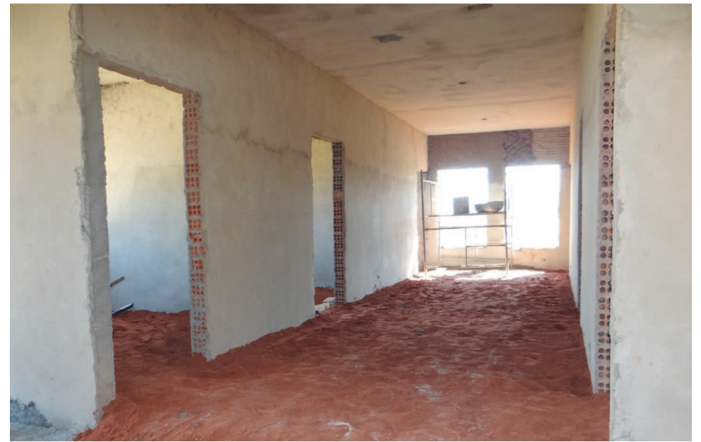
Reboque da parte interna do prédio do Posto de Saúde do Vera Cruz está concluído
