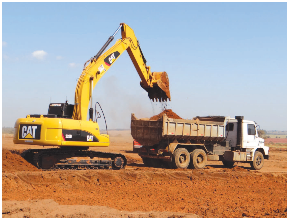
Início da construção das casas do Residencial São Rogério
