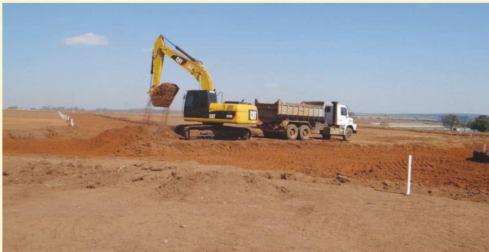
Início construção das casas do Residencial São Rogério
