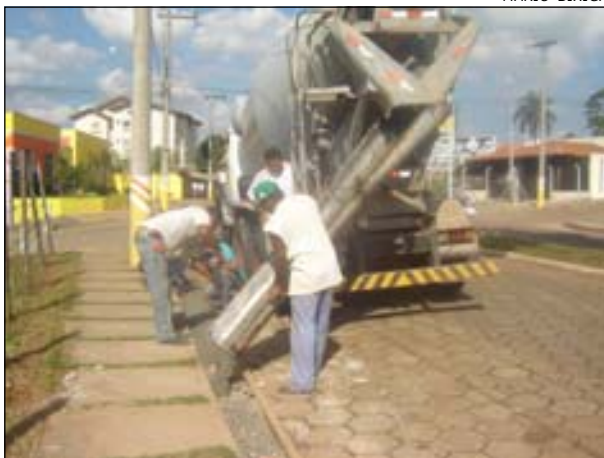
Iniciado trabalho de recapeamento da Avenida Misael Eufrásio Leal
