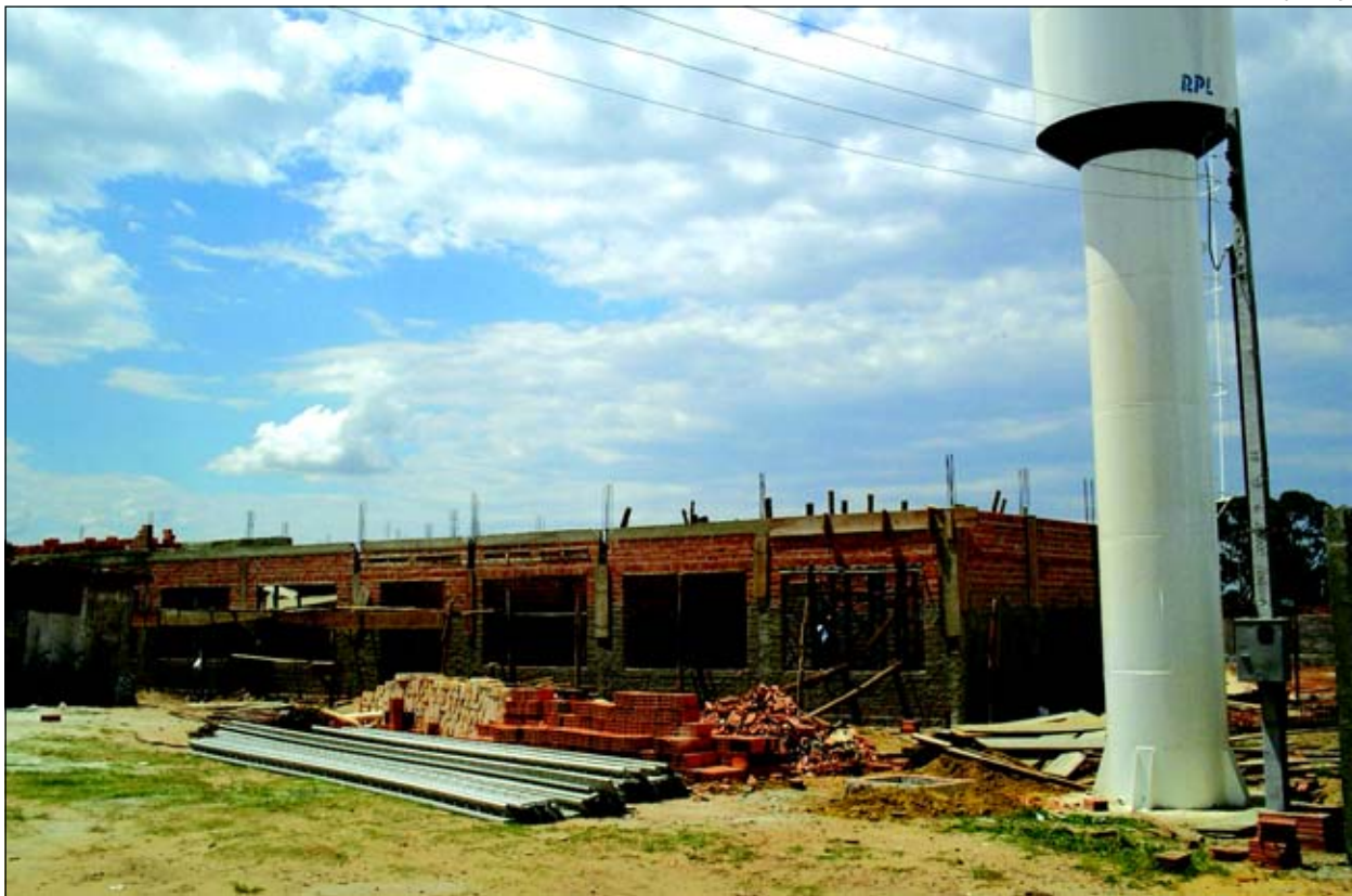
Creche está sendo construída em frente ao CSU
