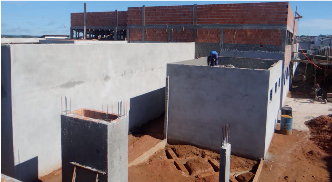
Futuras instalações da Unidade de Pronto Atendimento
