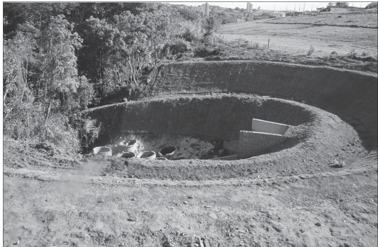
Galeria da Rua João Carvalho que foi reconstruída
