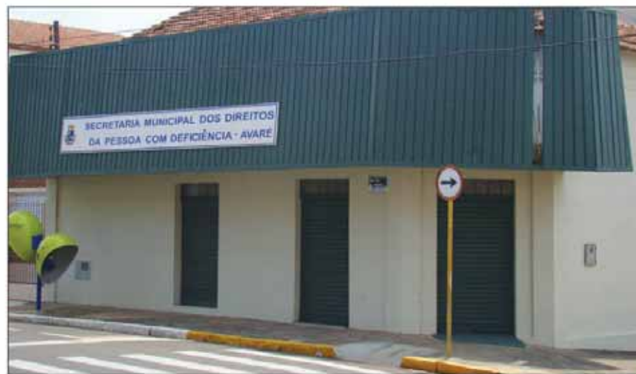
Prédio da Secretaria dos Direitos da Pessoa com Deficiência
