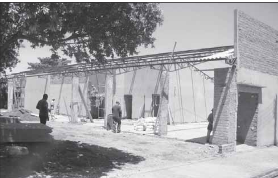
Obra de construção da escola
