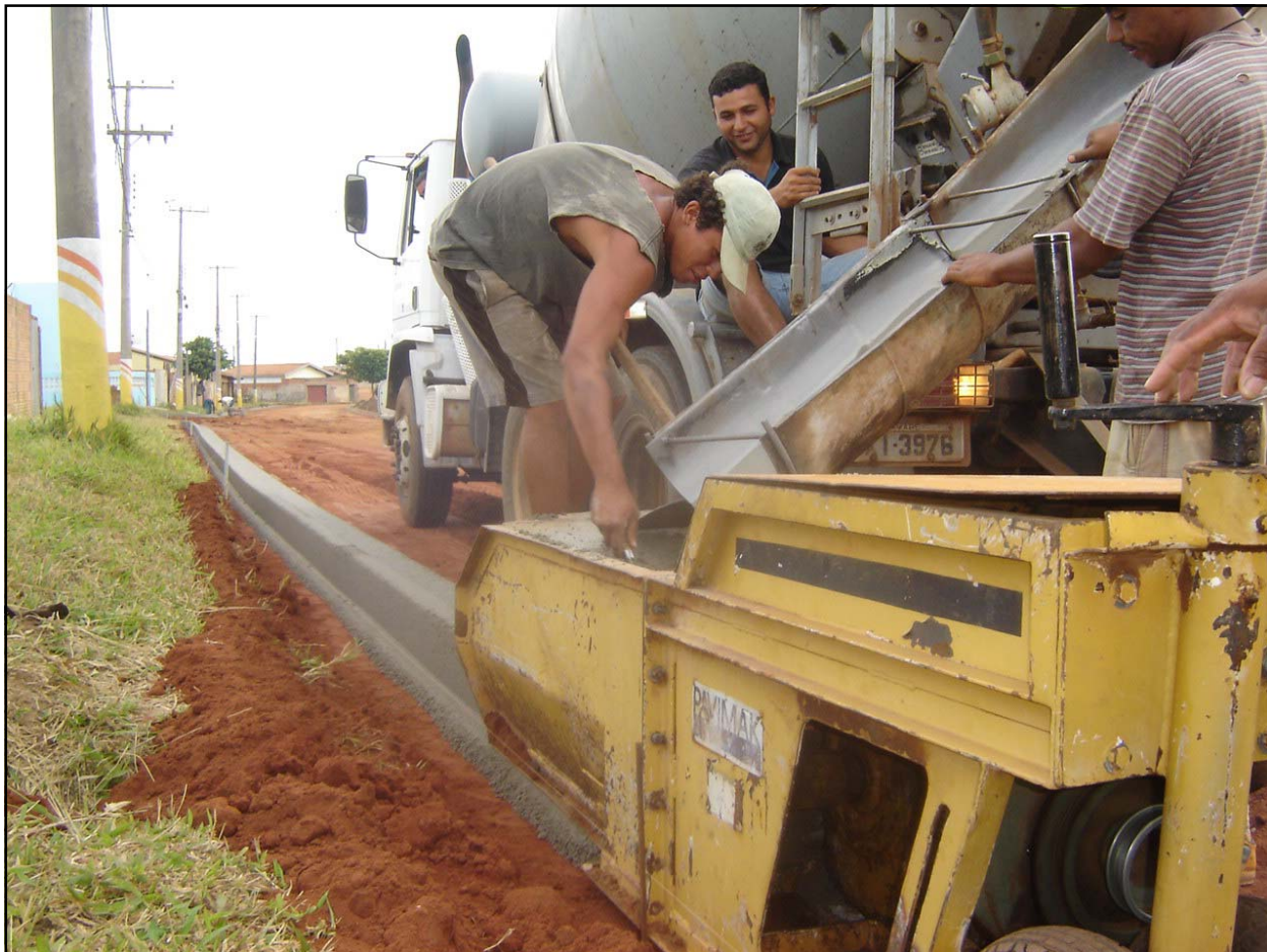
Colocação de guias na Rua Higino Roteli
