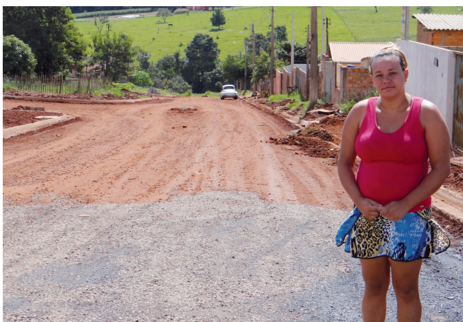
Serviço sendo executados há duas semanas
