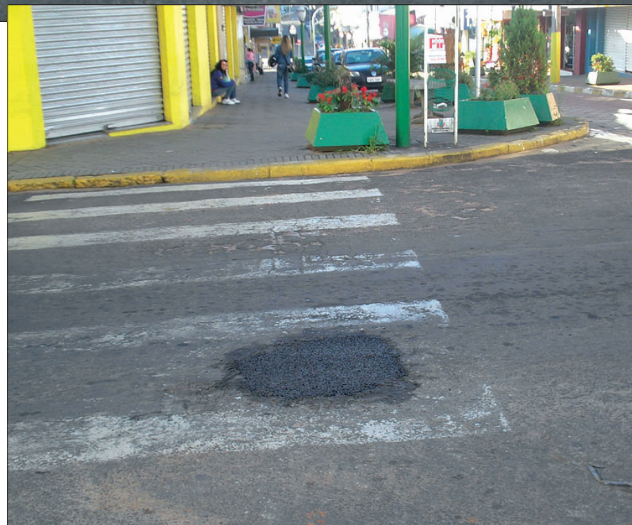
Serviço sendo executado nas ruas centrais da cidade
