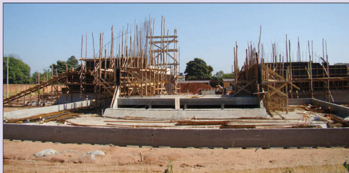
Construção do novo Fórum de Avaré
