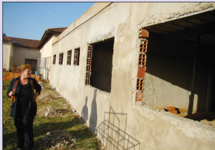
Ampliação e adequação do CEI Olga Girardi de Britto
