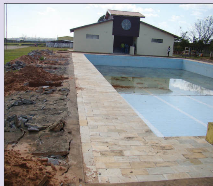
Construção da cobertura metálica da piscina do CSU
