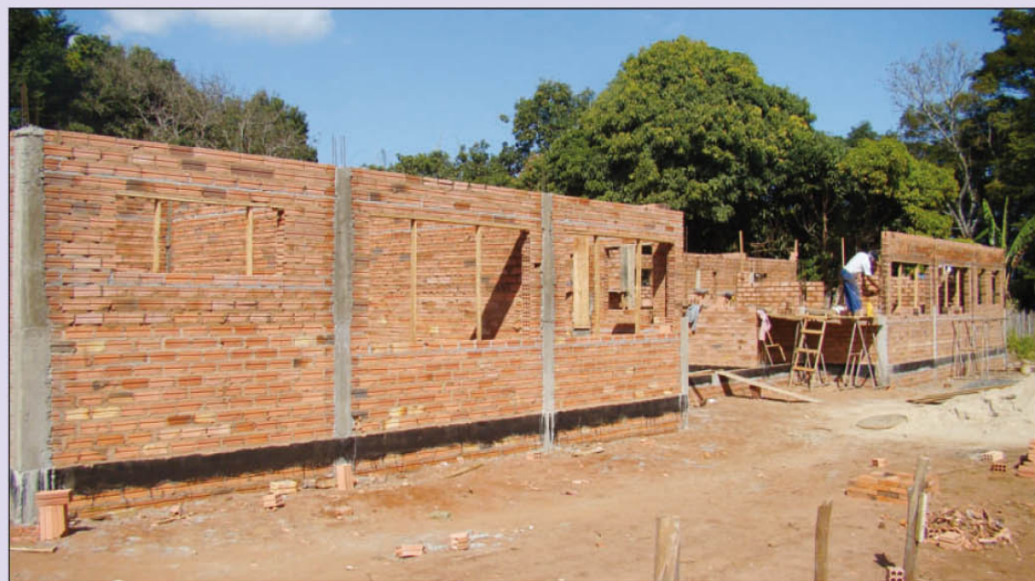
Construção do PAS do Bairro Ipiranga
