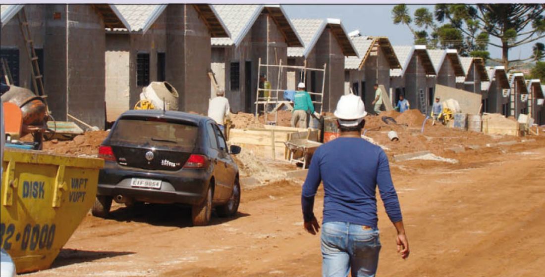
Construção de 220 casas em parceria com o SEC
