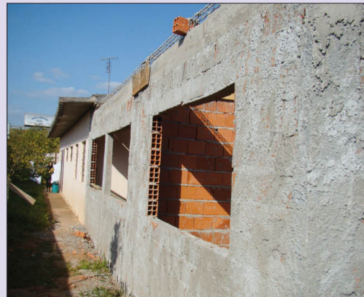
Ampliação e adequação do CEI Carolina Puzziolo
