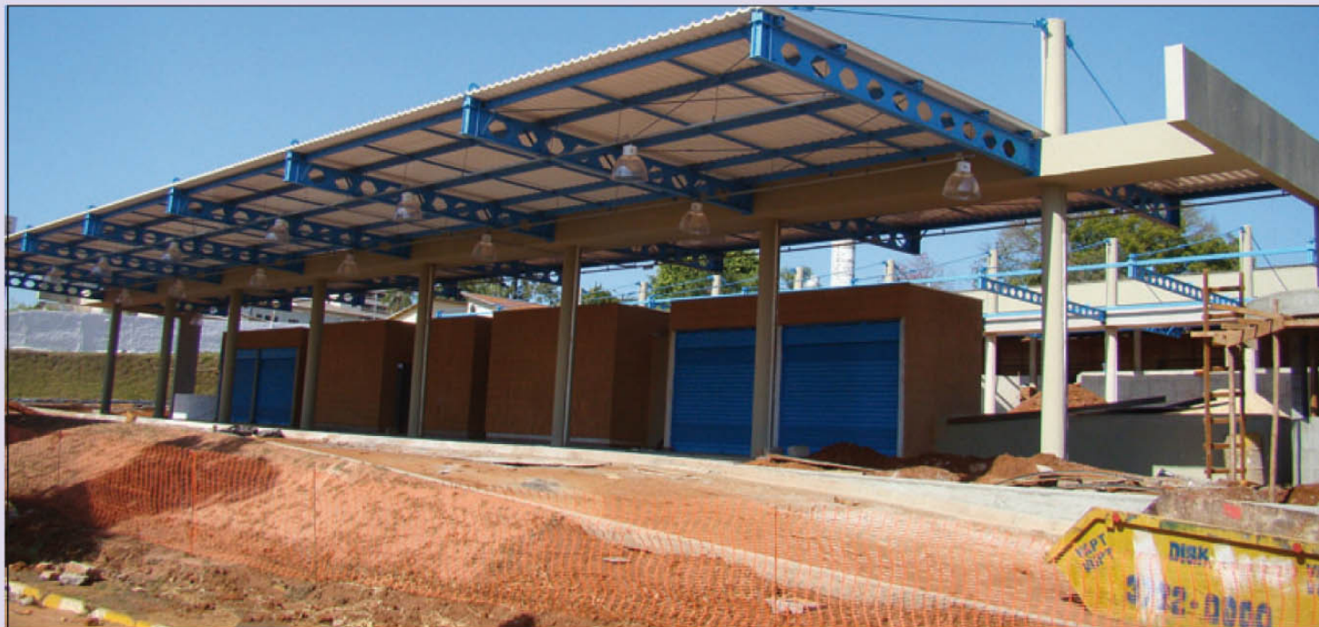
Reforma, ampliação e construção do Terminal Urbano da Rodoviária
