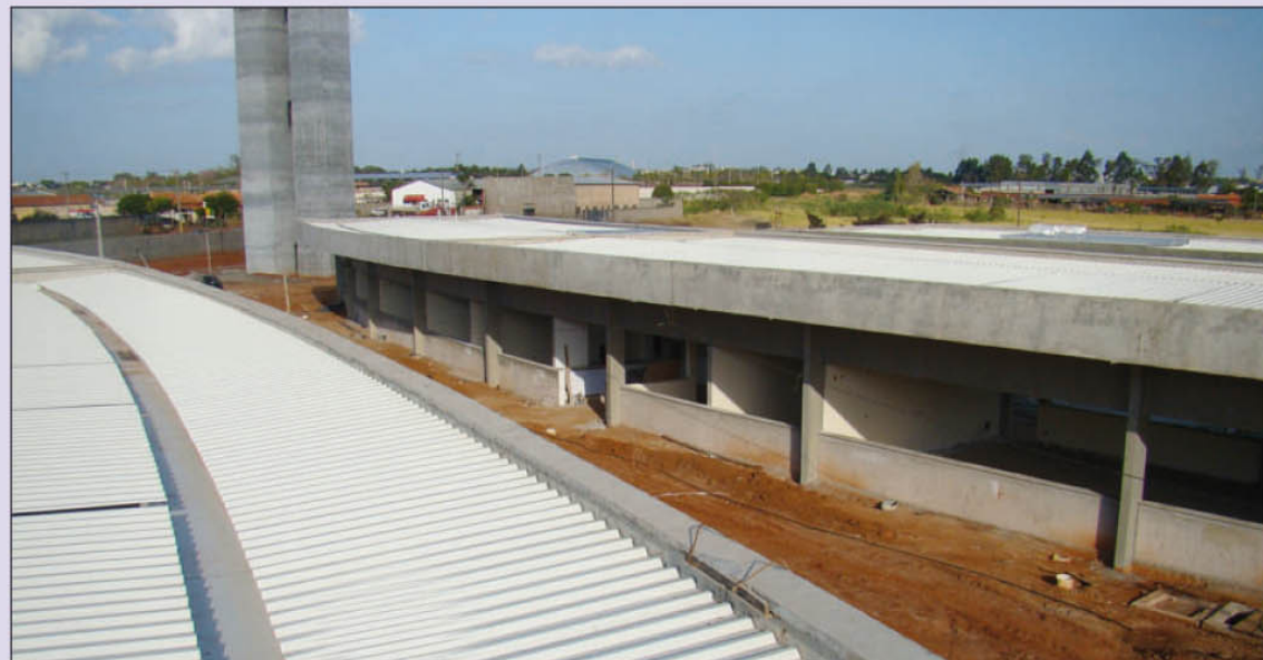
Construção da nova escola do SESI
