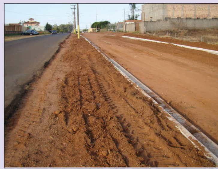
Pavimentação asfáltica da Avenida Mário Covas
